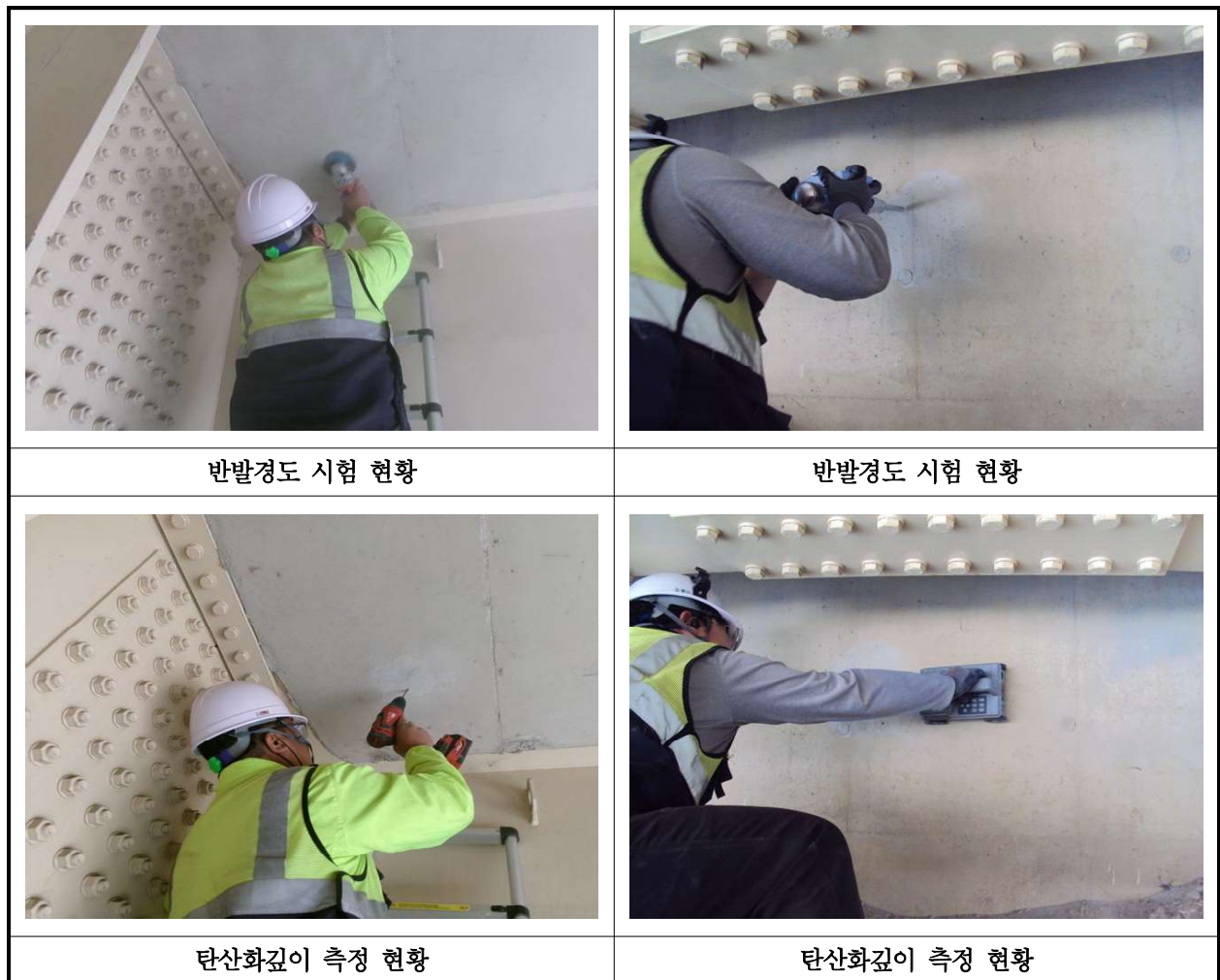
【사진 20.4.1】 콘크리트 내구성조사 현황
