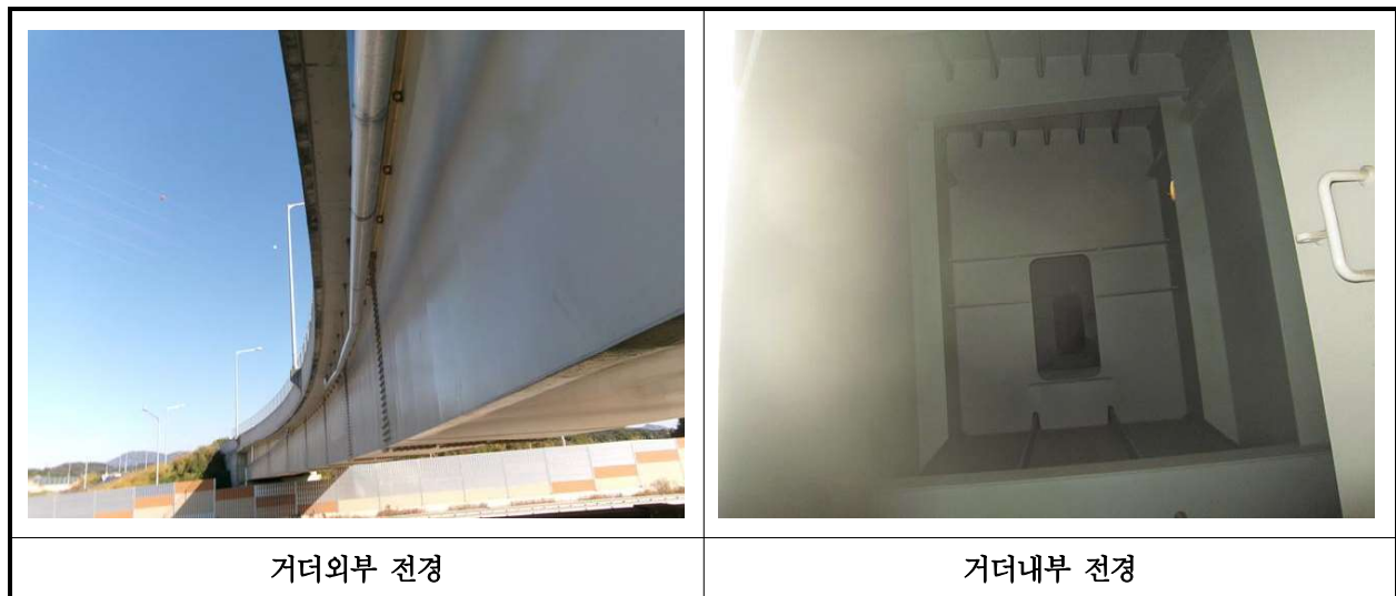
【사진 20.3.4】 거더 전경
