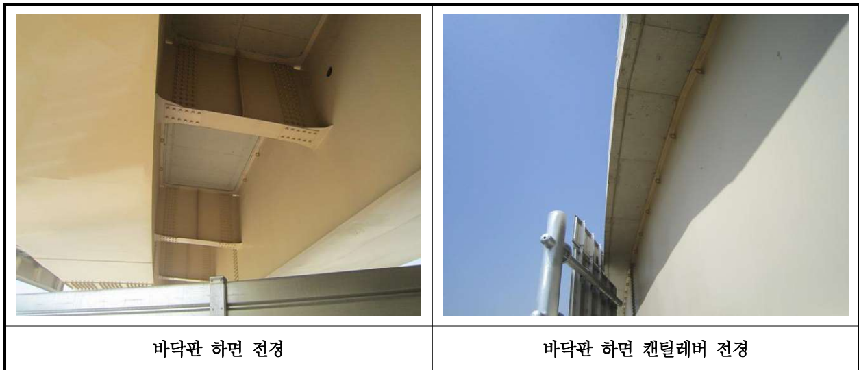
【사진 20.3.2】 바닥판하면 전경
