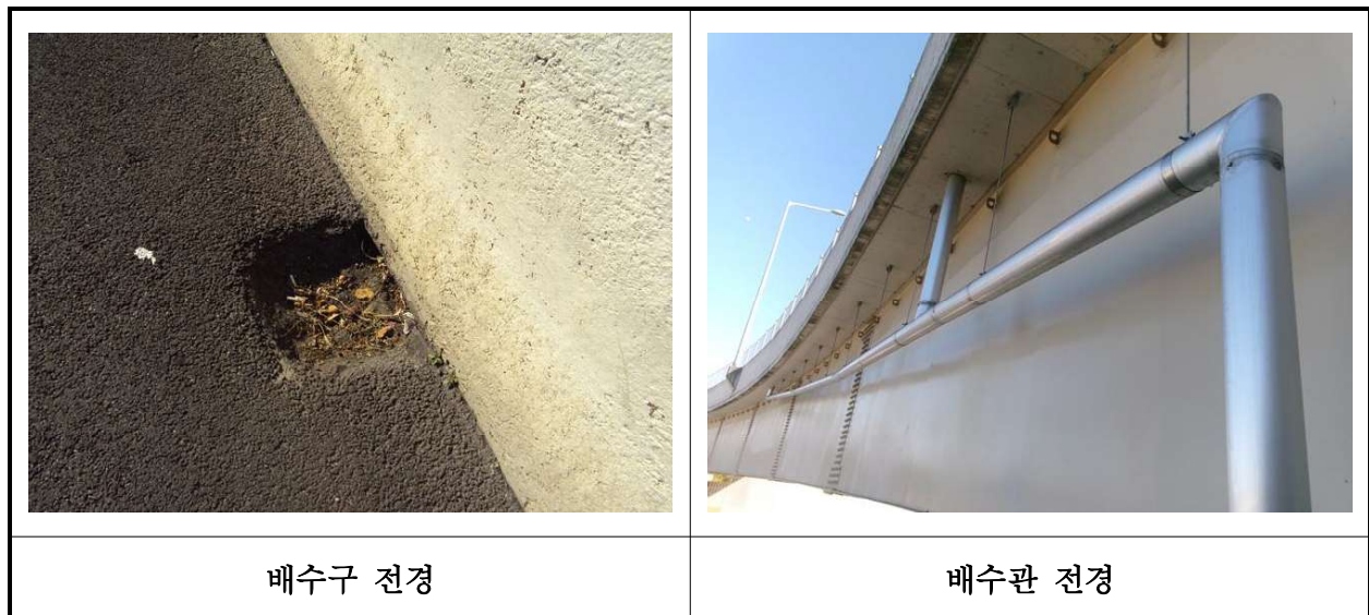
【사진 20.3.19】 배수시설 전경
