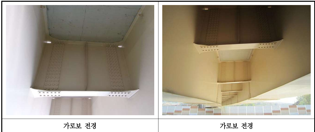
【사진 20.3.6】 가로보 전경
