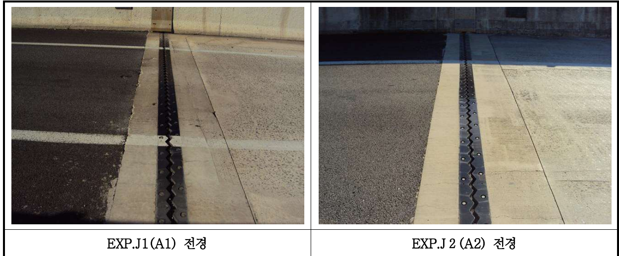
【사진 20.3.14】 신축이음장치 전경
