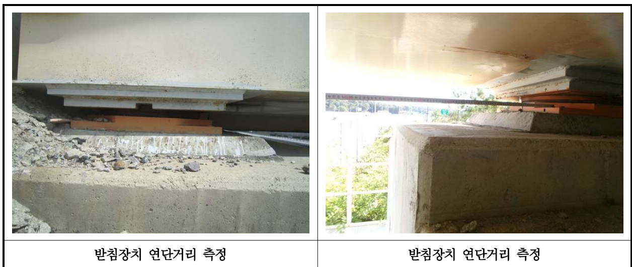
【사진 20.3.12】 교량받침장치 연단거리측정
