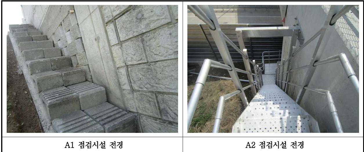
【사진 20.3.23】 교량 점검시설 전경
