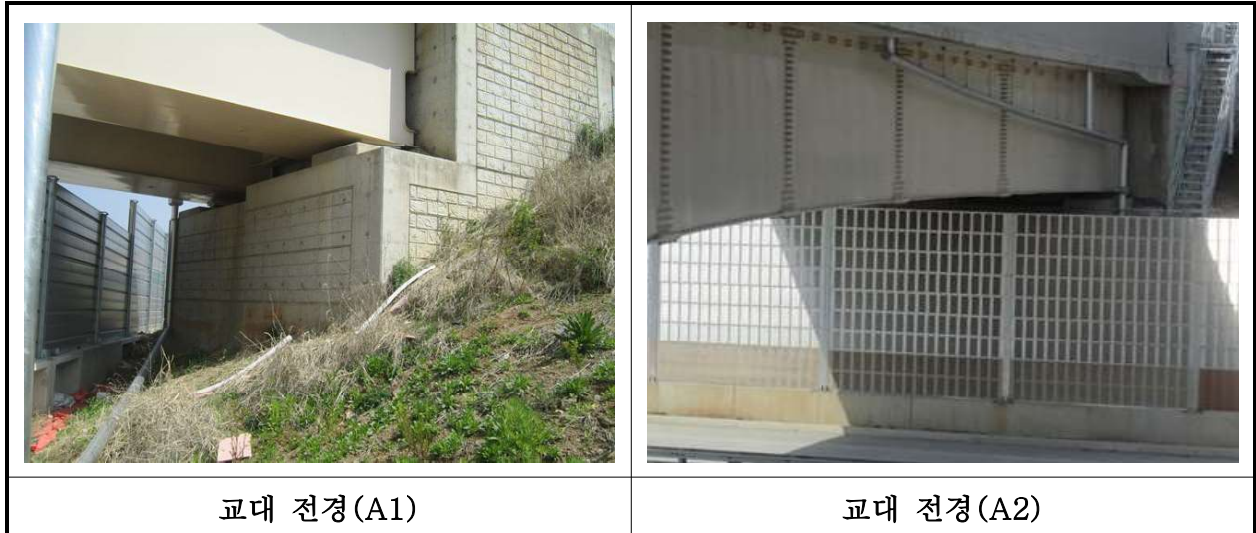
【사진 20.3.8】 교대 전경
