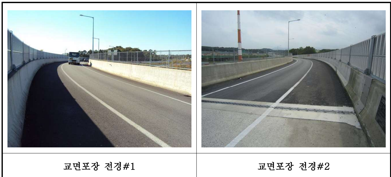
【사진 20.3.17】 교면포장 전경
