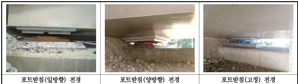
【사진 20.3.10】 교량받침 전경
