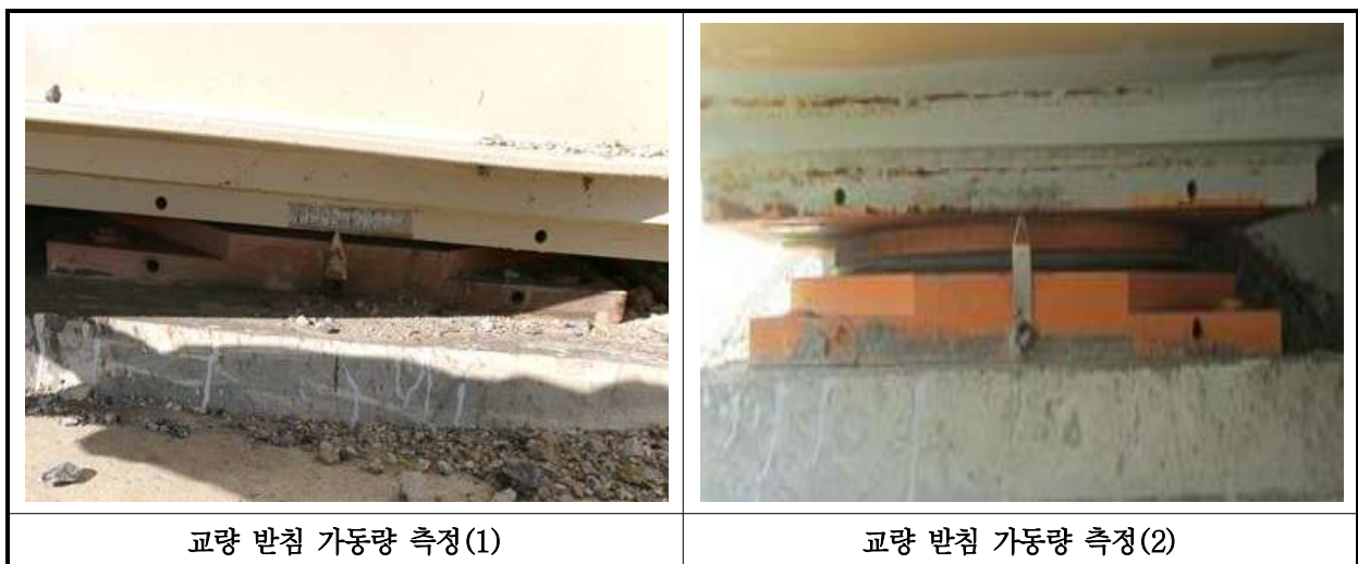
【사진 20.3.13】교량받침 이동량 측정
