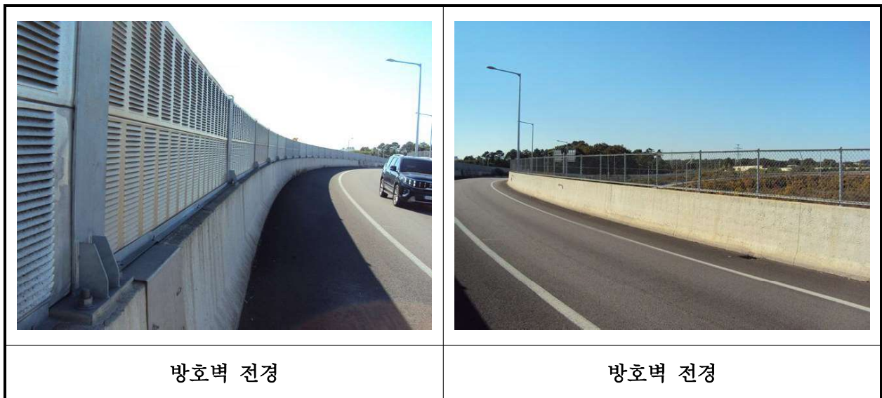
【사진 20.3.21】 방호벽 및 중앙분리대 전경
